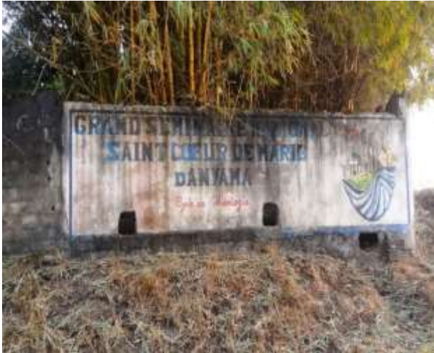
Vue de la clôture du GRAND SEMINAIRE D'ANYAMA
