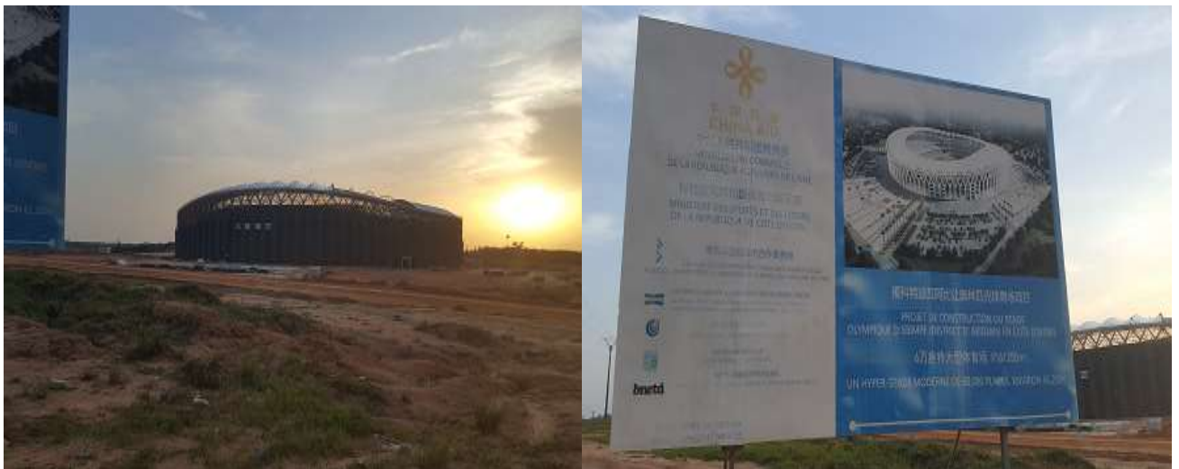
Vue du stade olympique d’Ebimpé en construction
