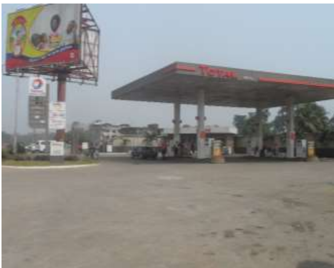
Vue d'une station-service TOTAL et un panneau publicitaire situés dans l'emprise des travaux à Yopougon
