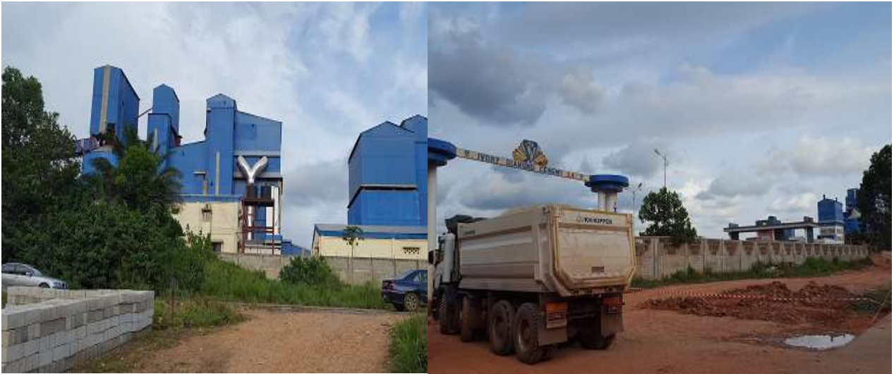
Figure 45. Vue de la cimenterie en construction à Anyama
