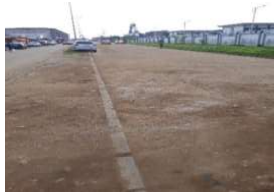
Photo 6 : Vue du PK 2,46 de la section 2 non revêtue
