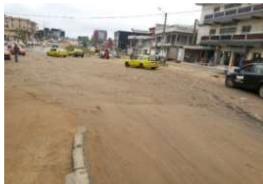
Photo 4 : Vue du PK 3,14 de la section 2 revêtue
