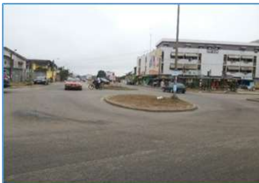
Photo 3 : Vue du PK 0 de la section 2 revêtue
