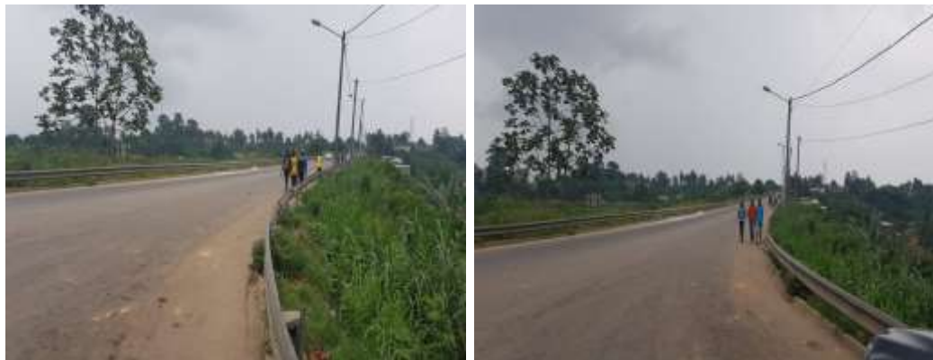
Photos 16 et 17: Voie de déviation au niveau du carrefour de l'ancien corridor d'Anyama (Source : Enquêtes BNETD, 2019)
