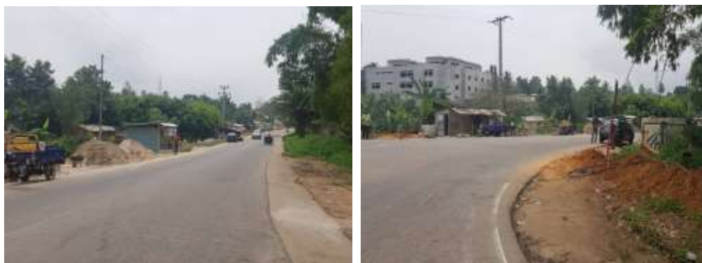
Photos 18 et 19: Voie de déviation au niveau du grand séminaire d'Anyama (carrefour Ebimpé) jusqu'à Anyama (Source : Enquêtes BNETD, 2019)
